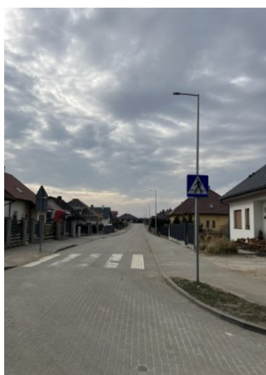
Fotografia 44: ul. Narcyzowa po odbiorze częściowym
