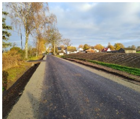
Fotografia 30: Stan drogi w Chelmońcu po zakończeniu realizacji projektu
