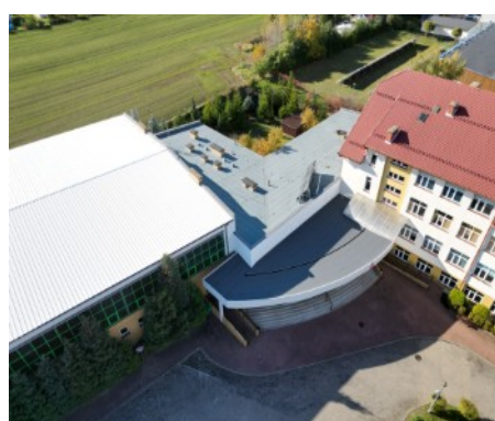
Fotografia 28: Szkoła Podstawowa w Kowalewie Pomorskim po zakończeniu III etapu zadania
