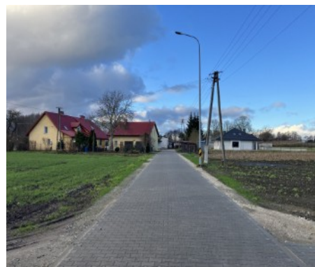
Fotografia 32: Fragment ulicy Główny Dworzec po zakończeniu realizacji inwestycji
