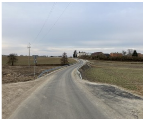
Fotografia 35: Bielsk, gmina Kowalewo Pomorskie DG 110117C – w trakcie budowy
