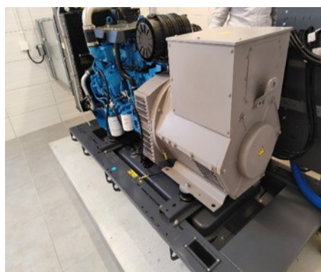
Fotografia 49: Stacja uzdatniania wody w Marianach po zakończeniu realizacji projektu
