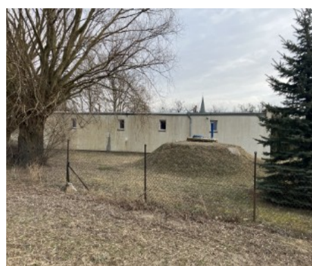
Fotografia 52: Stacja Uzdatniania Wody w Wielkiej Łące przed modernizacją
