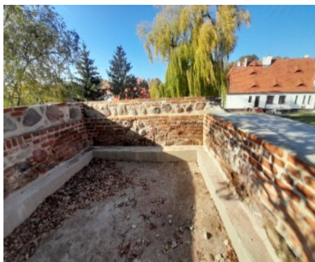
Fotografia 61: Mury miejskie po zakończeniu prac konserwatorsko - restauratorskich
