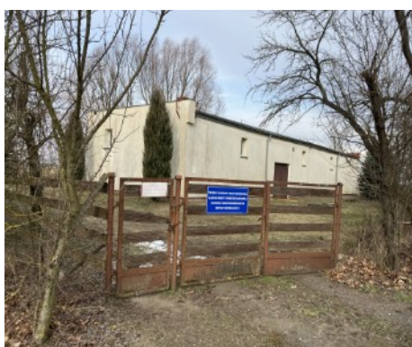
Fotografia 51: Stacja Uzdatniania Wody w Wielkiej Łące przed modernizacją
