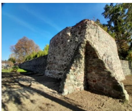
Fotografia 59: Mury miejskie po zakończeniu prac konserwatorsko - restauratorskich
