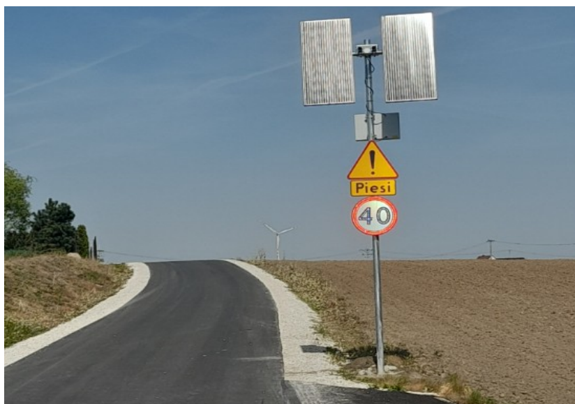
Fotografia 4: Remont drogi gminnej nr 110116C relacji Elzanowo - Mariany
