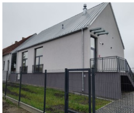
Fotografia 14: Świetlica wiejska w Bielsku po zakończeniu realizacji zadania
