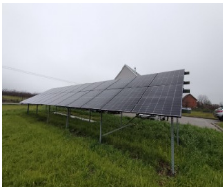
Fotografia 17: Świetlica wiejska w Bielsku po zakończeniu realizacji zadania
