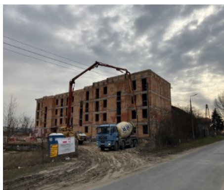
Fotografia 74: Budowa budynku mieszkalnego wielorodzinnego przy ul. Kościuszki w Kowalewie Pomorskim realizowanego przez Społeczną Inicjatywę Mieszkaniową „KZN-Toruński” Spółka z ograniczoną odpowiedzialnością w trakcie realizacji inwestycji
