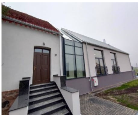
Fotografia 13: Świetlica wiejska w Bielsku po zakończeniu realizacji zadania
