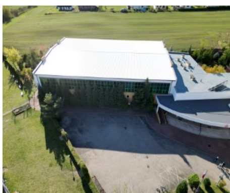
Fotografia 27: Szkoła Podstawowa w Kowalewie Pomorskim po zakończeniu III etapu zadania
