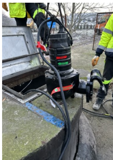
Fotografia 54: Prace montażowe jednej z pomp
