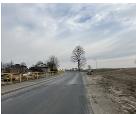
Fotografia 42: Przebudowana jezdnia drogi wojewódzkiej nr 649 w m. Srebrniki
