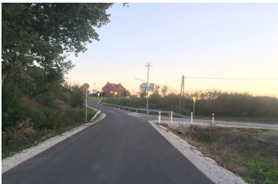
Fotografia 3: Remont drogi gminnej nr 110116C relacji Elzanowo - Mariany
