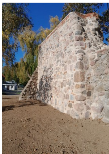
Fotografia 60: Mury miejskie po zakończeniu prac konserwatorsko - restauratorskich
