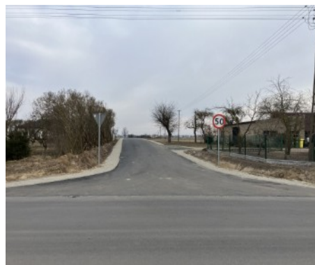
Fotografia 36: Lipienica, gmina Kowalewo Pomorskie DG 110117C – w trakcie prac
