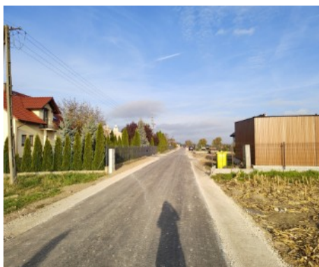
Fotografia 33: Droga w m. Bielsk po zakończeniu realizacji inwestycji
