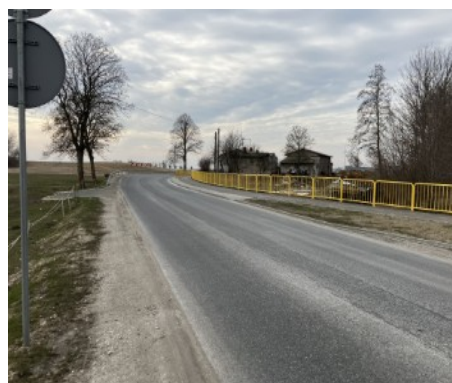
Fotografia 43: Przebudowana jezdnia drogi wojewódzkiej nr 649 w m. Srebrniki
