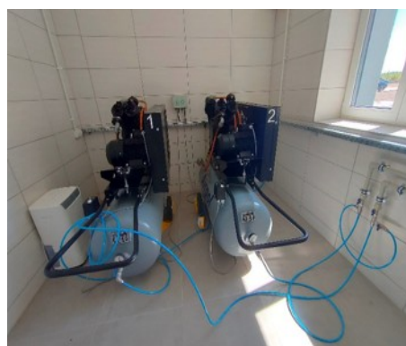
Fotografia 47: Stacja uzdatniania wody w Marianach po zakończeniu realizacji projektu
