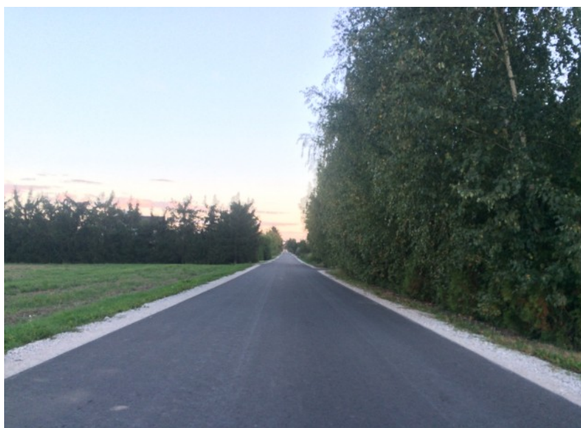
Fotografia 5: Remont drogi gminnej nr 110116C relacji Elzanowo - Mariany
