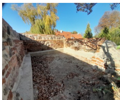
Fotografia 62: Mury miejskie po zakończeniu prac konserwatorsko - restauratorskich
