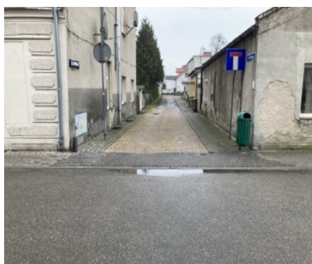
Fotografia 38: Ulica Murna w Kowalewie Pomorskim DG 110717C przed inwestycją
