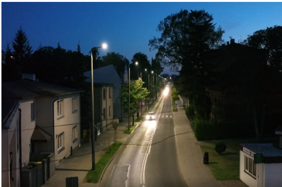
Fot. 3: Modernizacja oświetlenia ulicznego na terenie miasta i gminy Kowalewo Pomorskie
