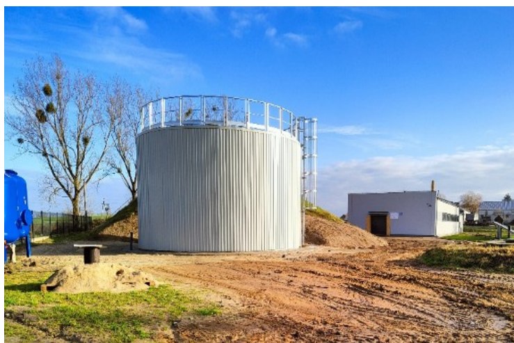
Fot. 19: Przebudowa SUW w Piątkowie
