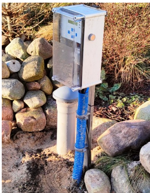
Fot. 20: Budowa kanalizacji w rejonie ulicy Główny Dworzec
