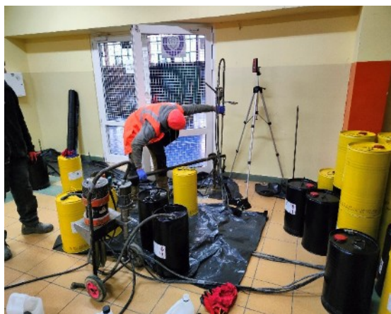
Fot. 9: Termomodernizacja hali sportowej i łącznika w zakresie ocieplenia dachu oraz wykonanie fundamentów wzmacniających w hali sportowej
