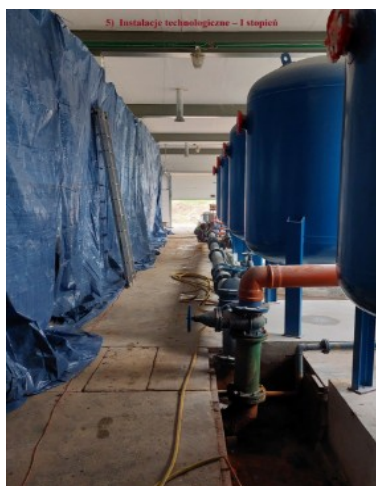
Fot. 18: Przebudowa SUW w Piątkowie
