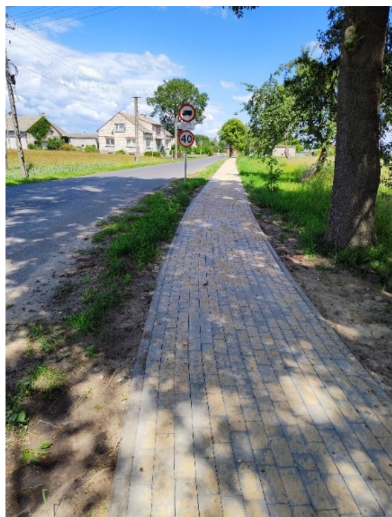
Fot. 16: Wybudowany chodnik w miejscowości Mlewo
