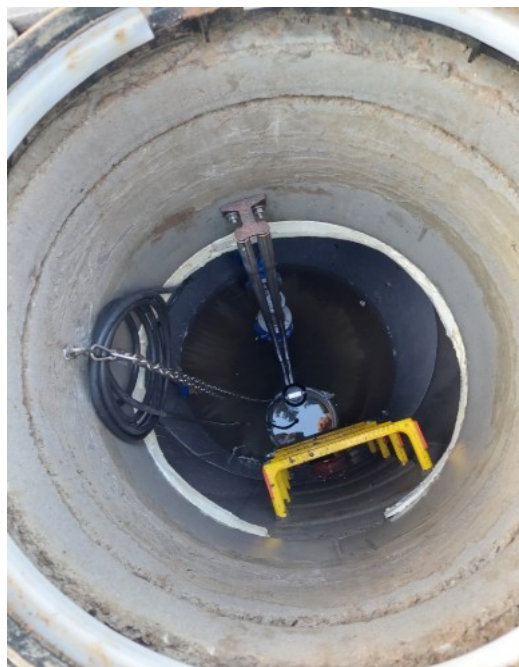
Fot. 21: Budowa kanalizacji w rejonie ulicy Główny Dworzec
