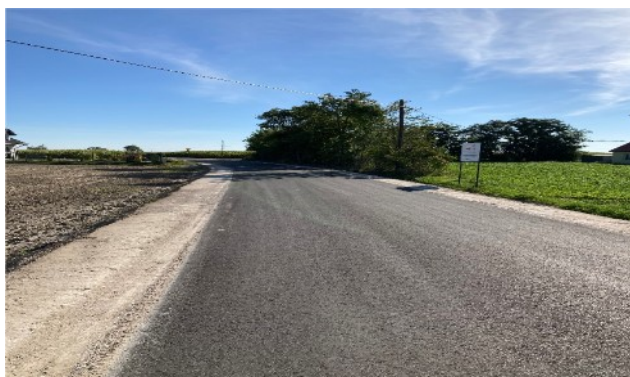
Fot. 13: Przebudowa drogi gminnej Szychowo - Elzanowo
