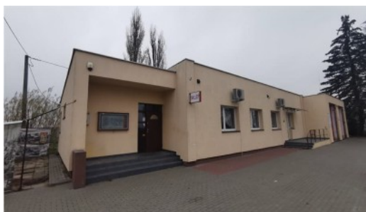
Fot. 11: Elewacja budynku świetlicy w Sierakowie przed remontem
