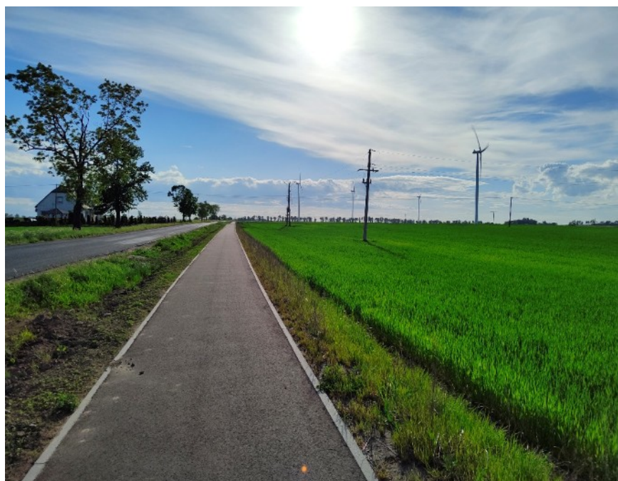
Fot. 17: Realizowana droga dla rowerów w miejscowości Srebrniki
