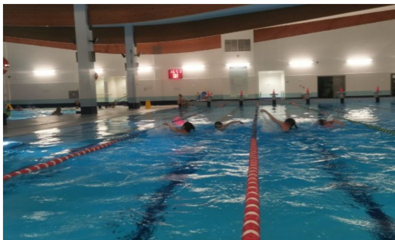
Fot. 35: Hala basenowa w Kowalewie Pomorskim
