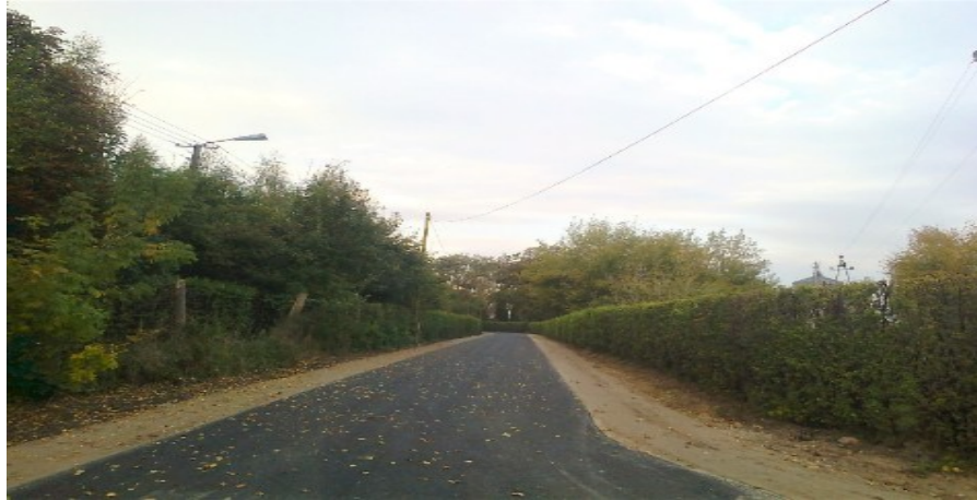
Fot. 16: Przebudowa drogi gminnej na działce numer 19/1
