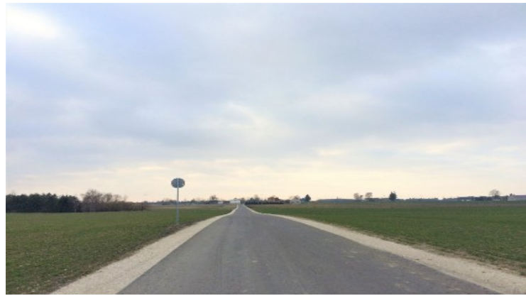
Fot. 14: Przebudowa drogi gminnej Mlewo - Mlewiec
