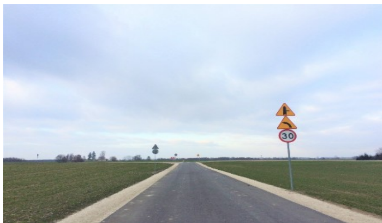
Fot. 13: Przebudowa drogi gminnej Mlewo - Mlewiec
