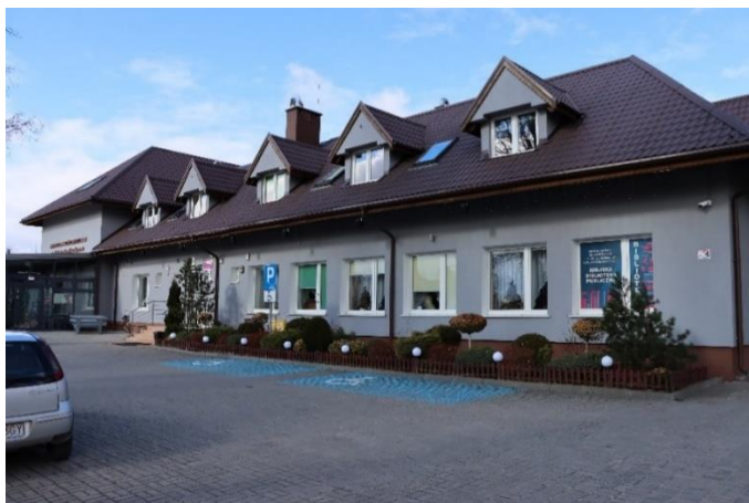
Fot. nr 79 Budynek M-GOK
