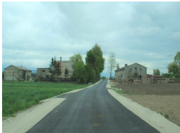
Fot. nr 5 Przebudowa drogi w miejscowości Zapluskowęsy
