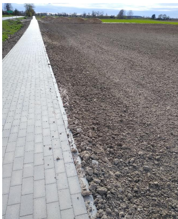
Fot. nr 3 Chodnik wzdłuż drogi krajowej
