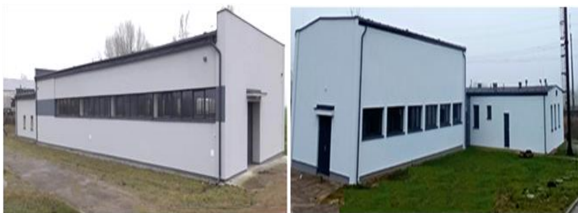
Fot. nr 17-18 Termoodernizacja stacji uzdatniania wody w Piątkowie i Marianach
