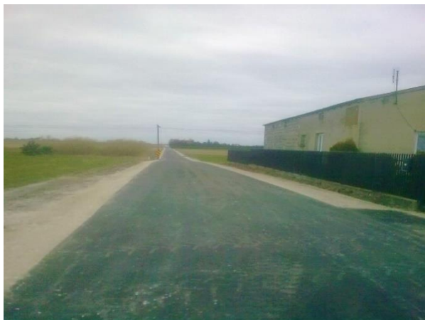
Fot. nr 4 Przebudowa drogi w miejscowości Szychowo
