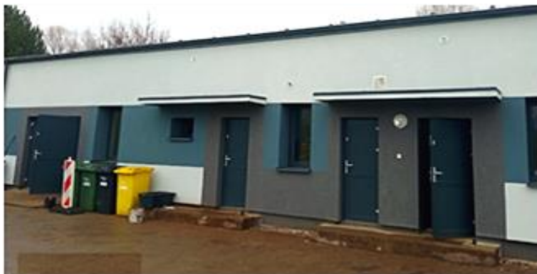
Fot. nr 19 oczyszczalnia ścieków w Kowalewie Pomorskim
