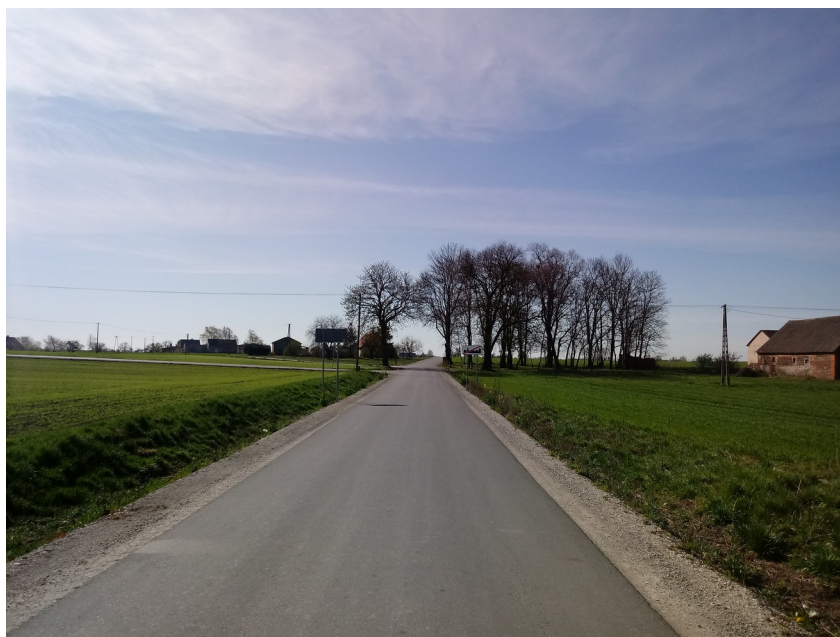
Fot. droga gminna nr 110129C na odcinku Napole – Pluskowęsy
