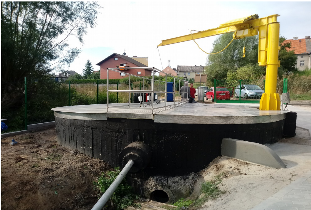
Fot. Przepompownia ścieków w Kowalewie Pomorskim
