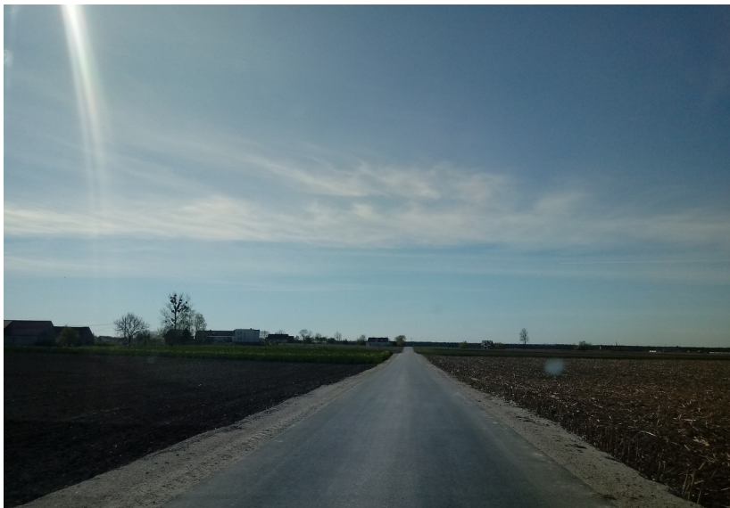
Fot. droga gminna nr 110154C relacji Wielka Łąka - Pruska Łąka
