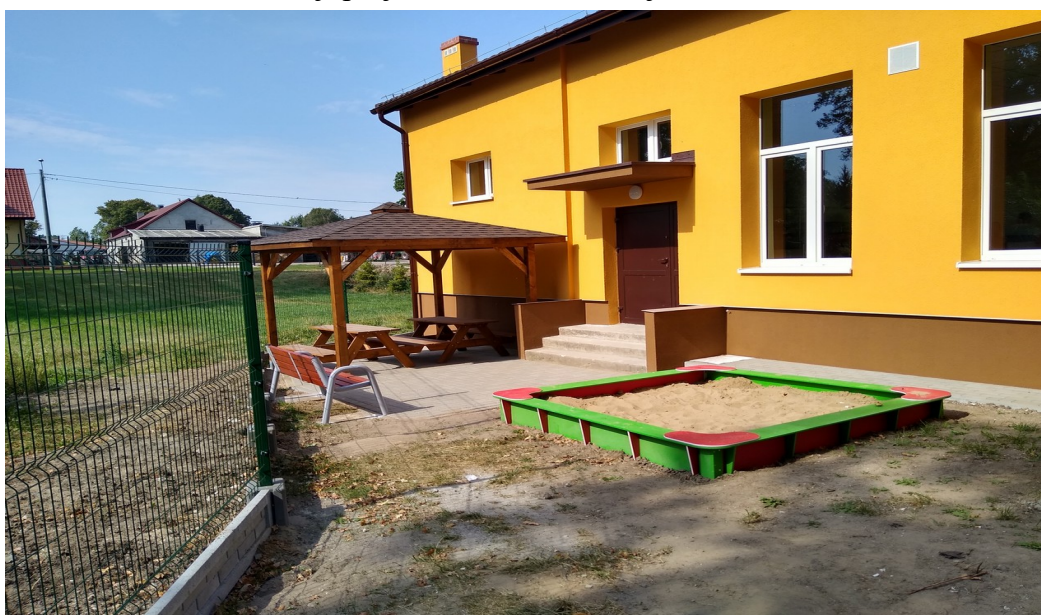
Fot. Remizo - świetlica w Chełmońcu
