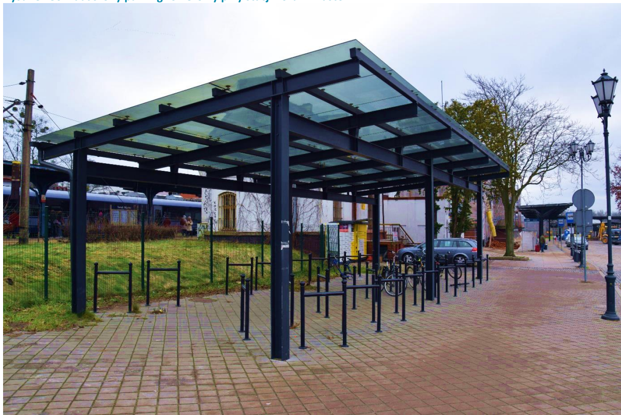
Rysunek 80. Zadaszony parking rowerowy przy stacji Toruń Miasto PKP.
