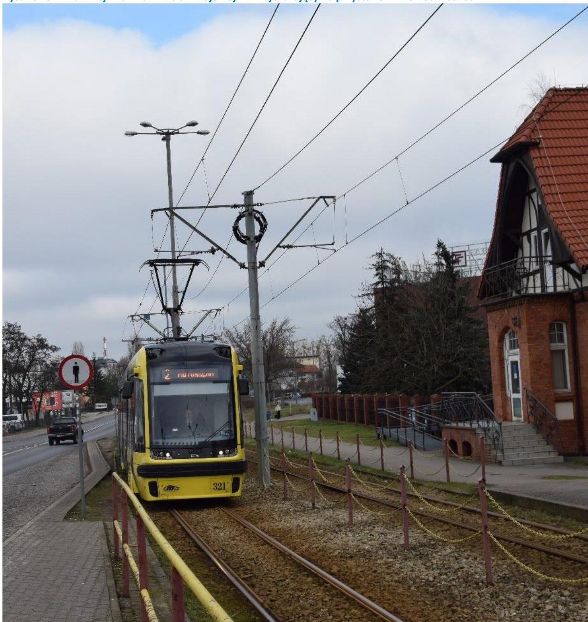
Rysunek 51. Tramwaj PESA na linii tramwajowej nr 2 wjeżdżający na przystanek Dworzec Wschodni
