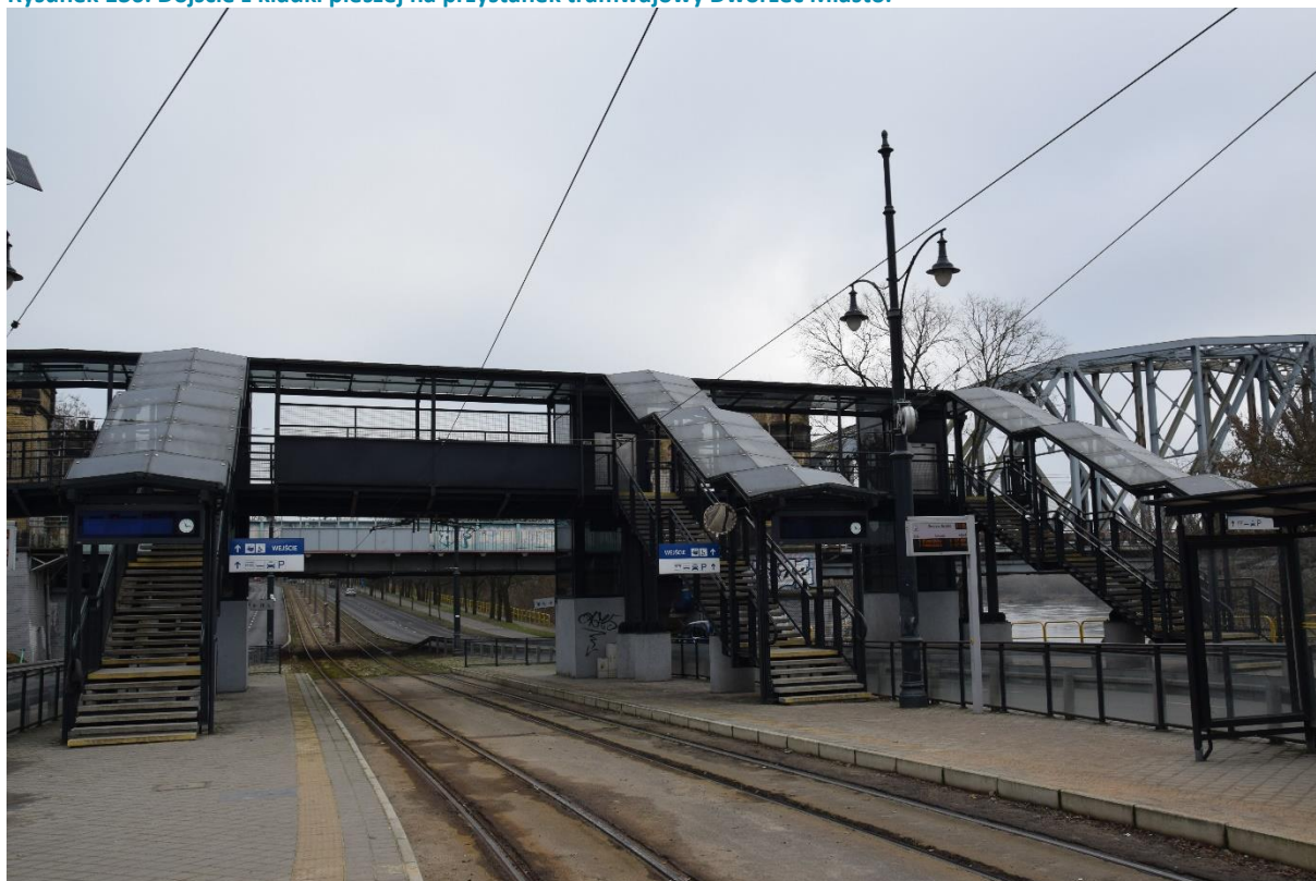
Rysunek 136. Dojście z kładki pieszej na przystanek tramwajowy Dworzec Miasto.
